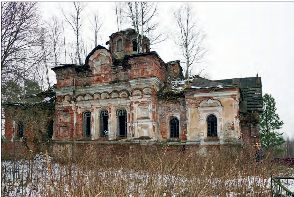
Северный фасад Казанской церкви села Бакунино
